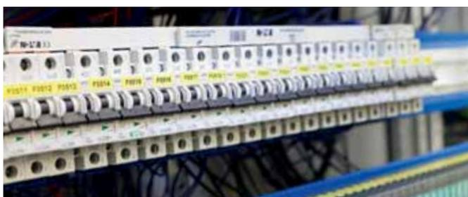
La structure du repérage des matériels, ordonnés par fonction, est logique. Dans l'armoire de commande WEINIG, chaque composant est identifié par un numéro précis. En cas de dysfonctionnement, le client n'a qu'à fournir ce numéro au service clientèle WEINIG. C'est d'un intérêt très précieux pour garantir une disponibilité élevée des machines.
